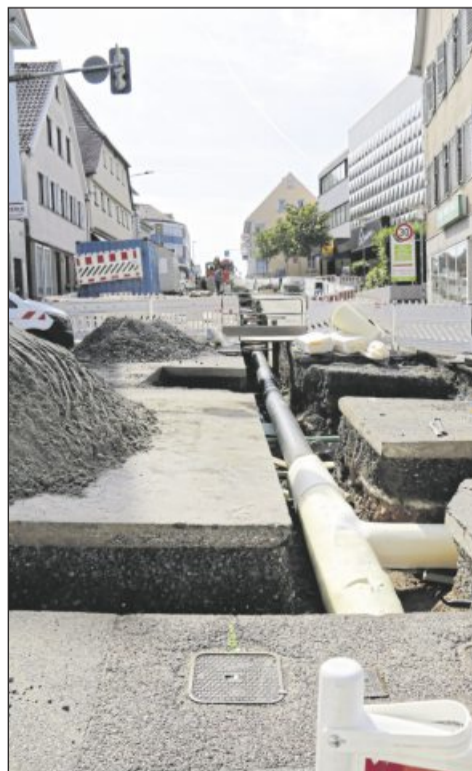
In der Stuttgarter Straße wurden Leitungen für die Nahwärmeversorgung verlegt.
