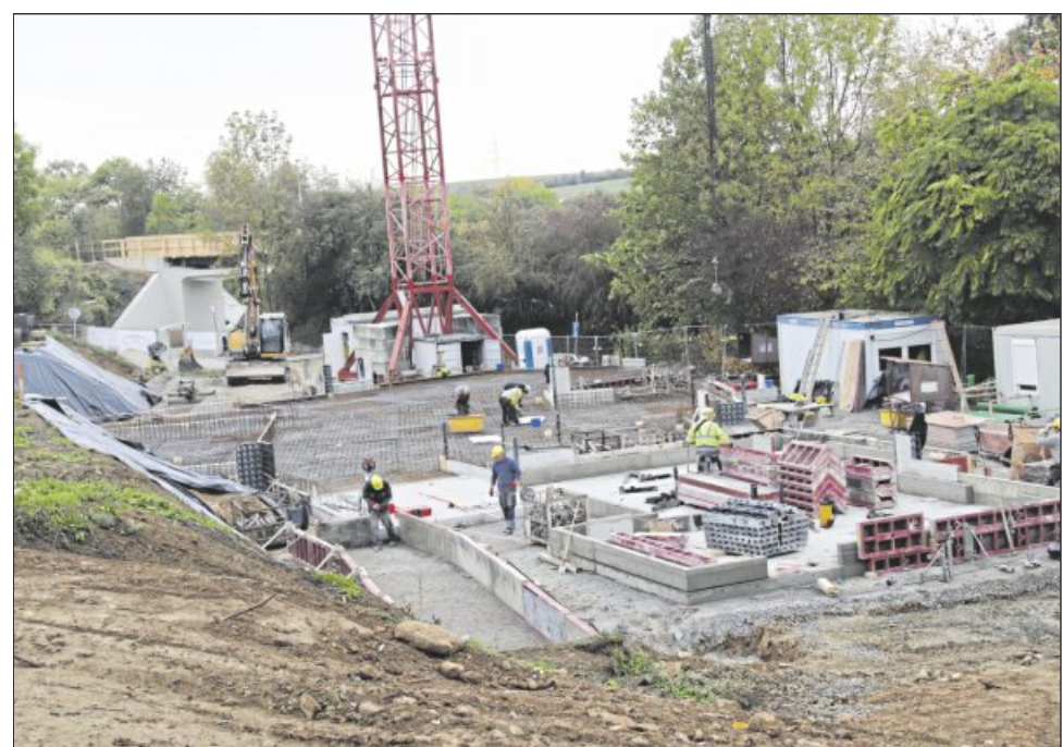
Die Bauarbeiten für den neuen Waldorfschule laufen seit Mitte September. Foto: Arning
