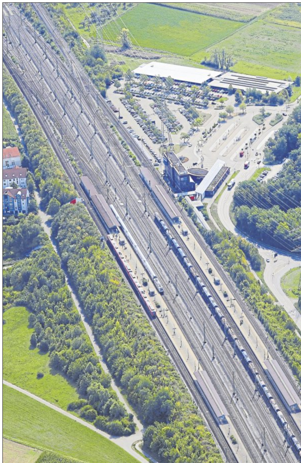
Auf diesen Flächen wird ein energieautarkes Wohnquartier entstehen.
