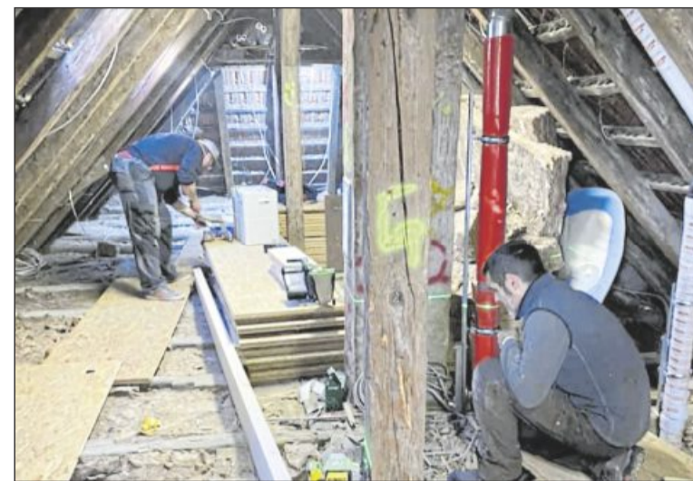
Fotos: p Alles Eigenleistung: Der Jugend- und Freizeitclub beim Dachausbau.
